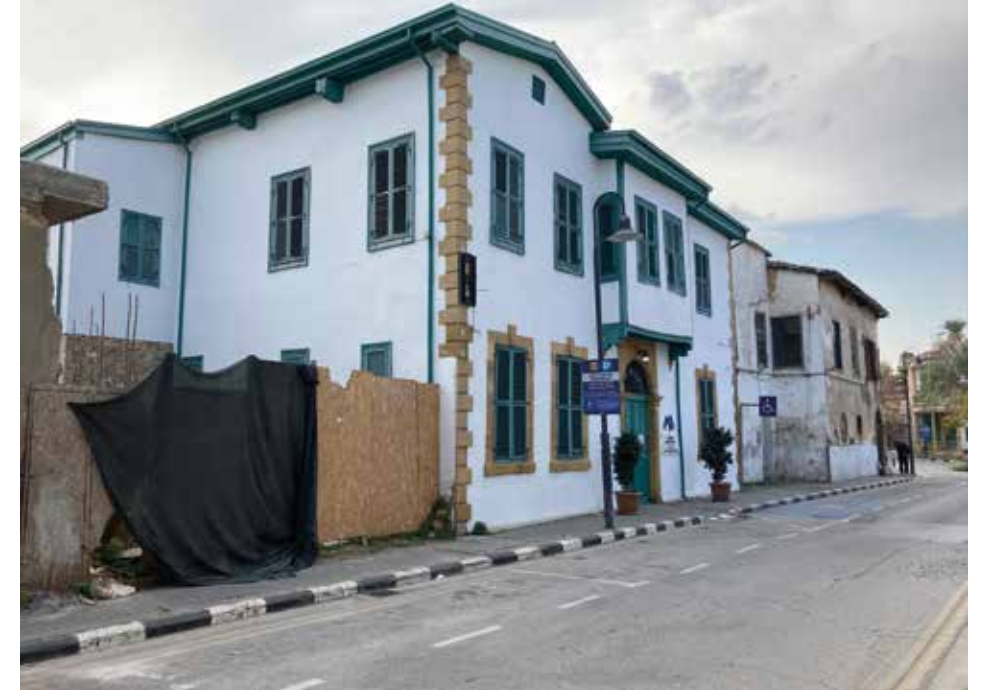
Şekil 28c: Yapının restorasyondan sonrası ön cephe görünümü (Mimarca, 2018)
