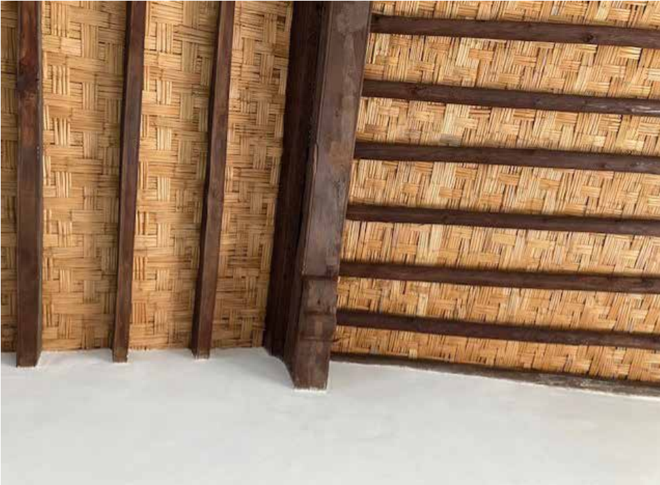
Şekil 23a/b: Ahşap tavan, mertek ve kamışların bakım sonrası görüşleri (Menteş, 2017)
