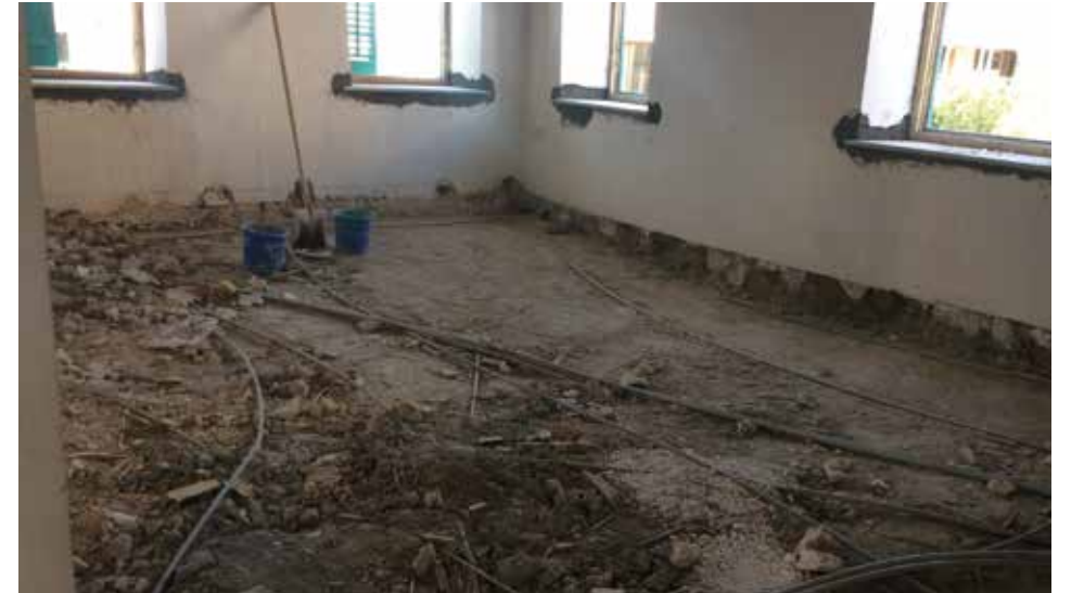
Şekil 16a/b/c/d: Birinci katın giriş holü döşemesindeki kırık Kıbrıs mermerlerinin ve Oda 5'teki niteliksiz ve çürümüş ahşapların söküm işleri (Menteş, 2016)
