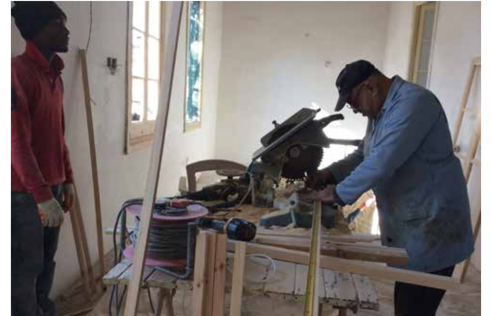
Şekil 24: Yerel ahşap ustası Ahmet Mişon binanın ahşap işlerini yaparken (Menteş, 2016)
