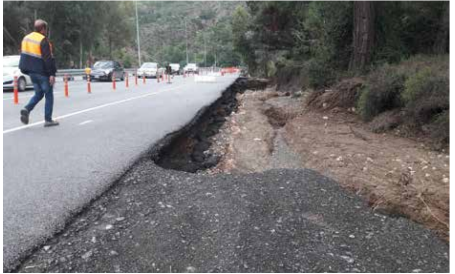
Figür 3: Yola çıkan suyun meydana getirdiği erozyon
