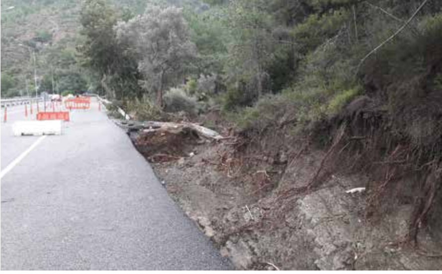
Figür 4: Yola çıkan suyun meydana getirdiği erozyon
