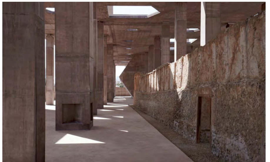
Figür 4: Beton duvarların pürüzlü yüzeyleri
