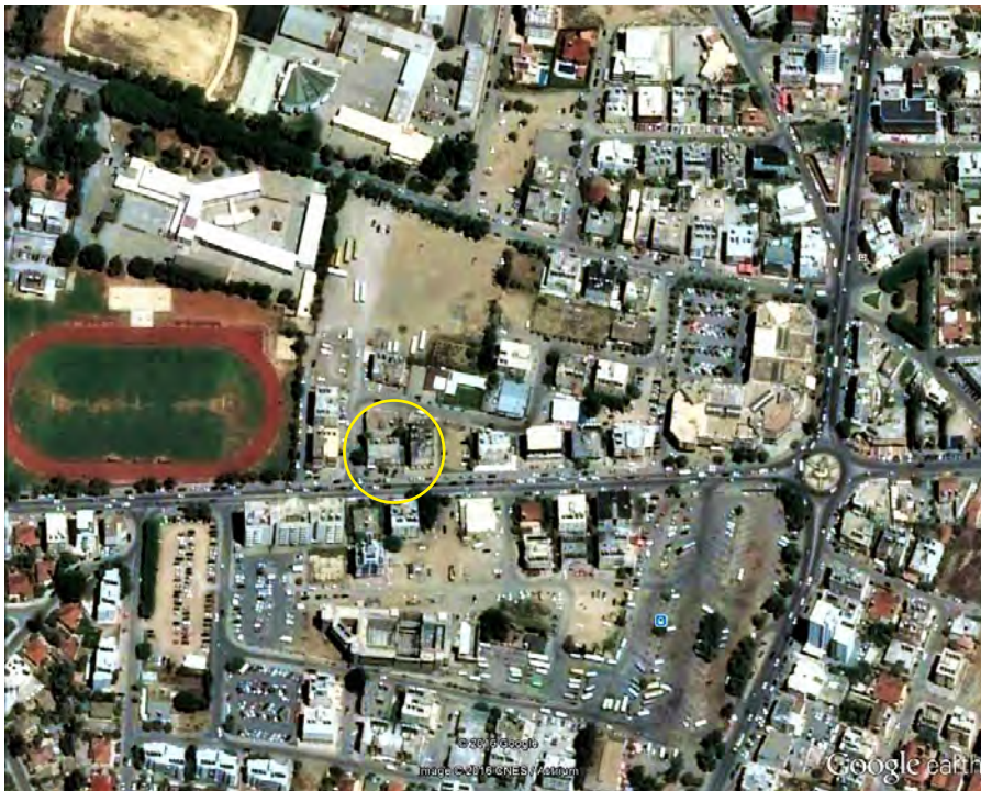
Figür 19: Lefkoşa Belediye Tiyatrosu inşaatının günümüzdeki durumu
