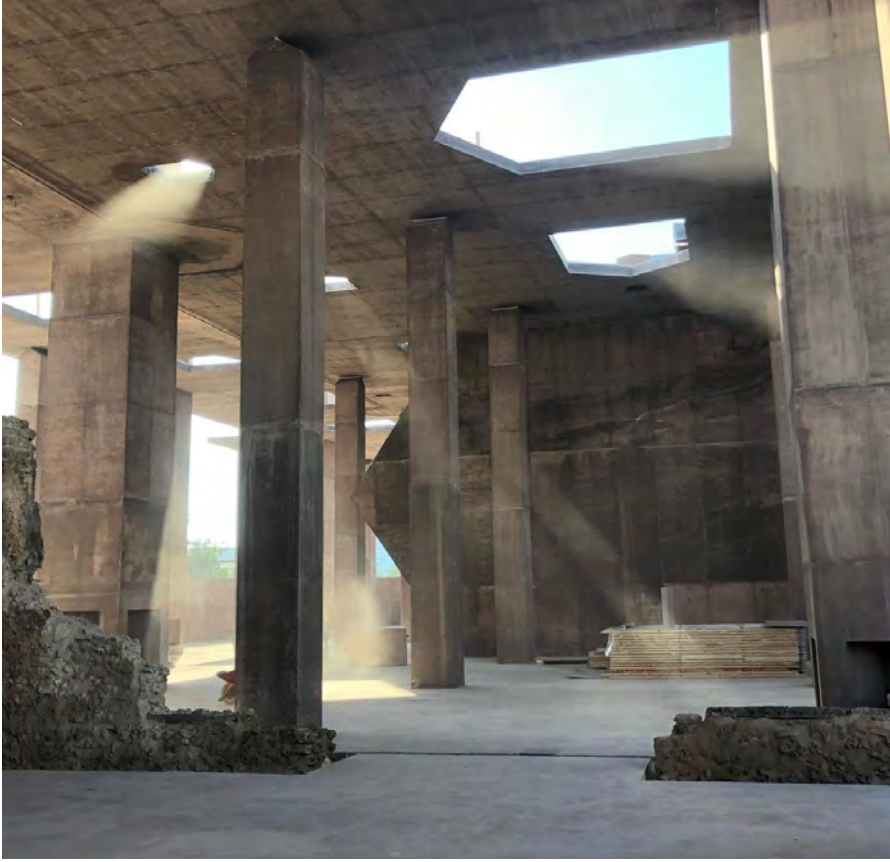
Figür 5: Beton üst örtüden sızan ışık, dalış tecrübesine referans verir
