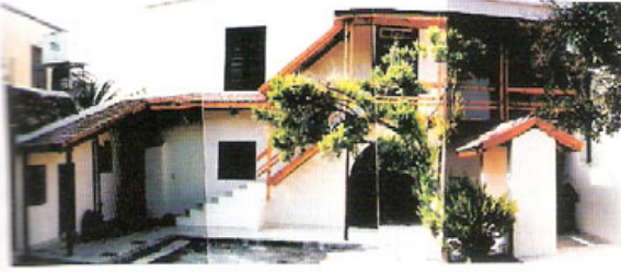
Resim 21. G. Burton Renovasyon Projesi, Girne (T.Veysi'nin arşivinden)
