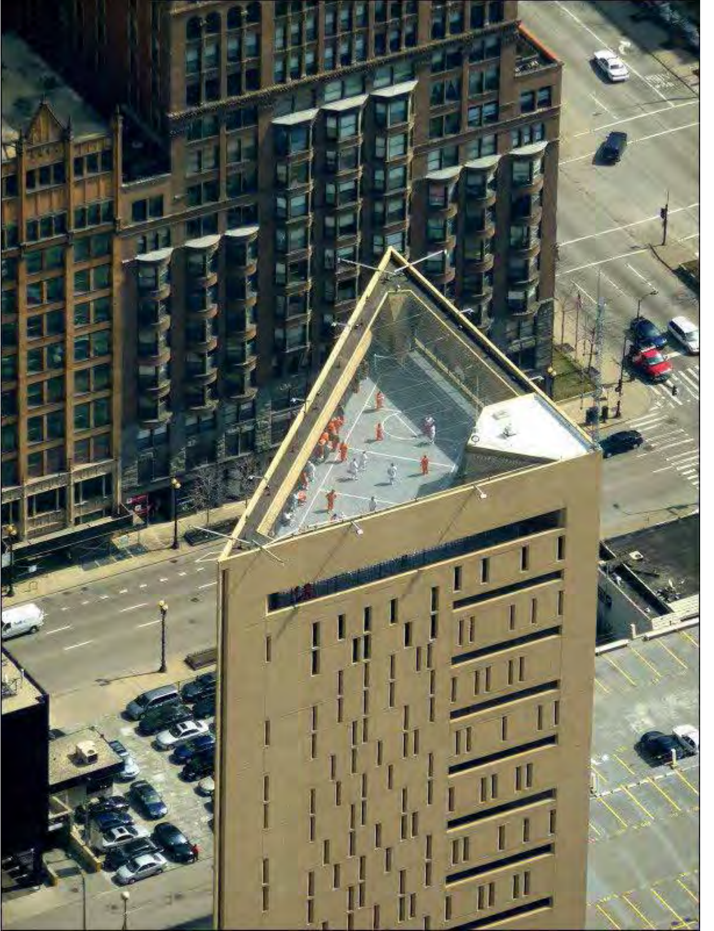
Figür 4: Chicago Hapishanesi, Çatı Alanı
