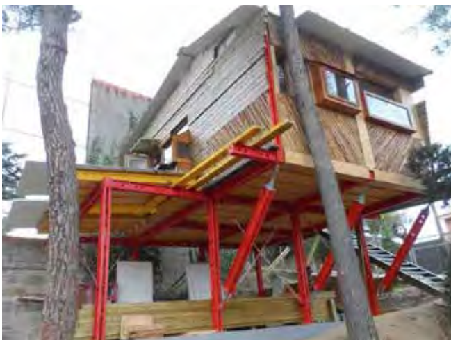
Figür 30-35: Tretzevents, Sant Cugat del Valles, 2013 (Fotoğraflar: Recetas Urbanas)
