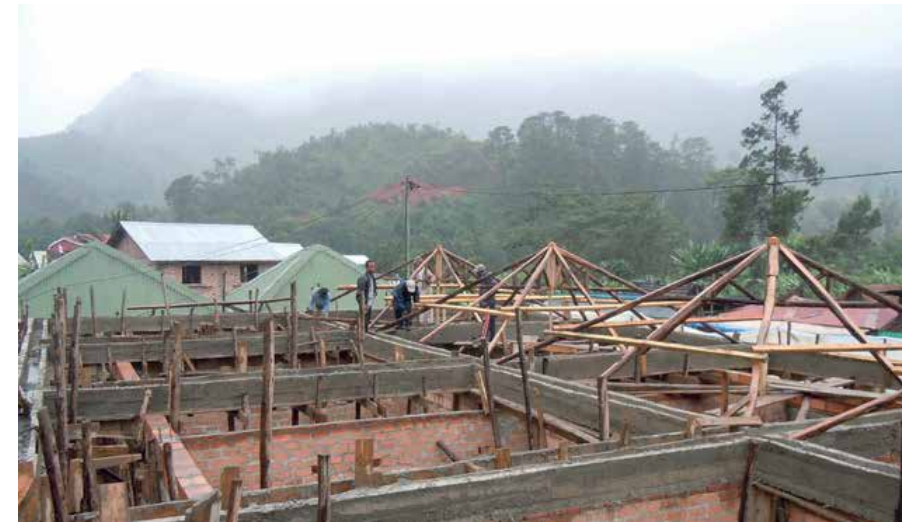
Figür 5 ve 6 – Ranomafana Pazar Binası Piramidal Modüllü Çatının İnşası
