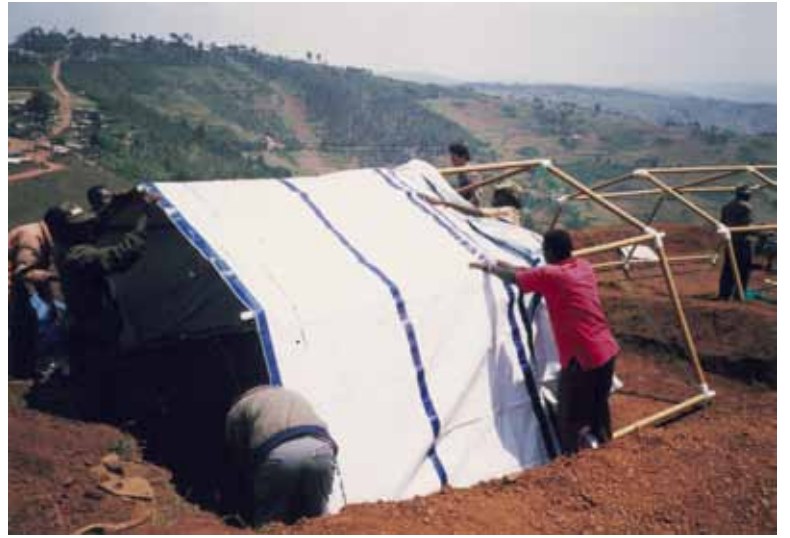
4 ve 4.1. Kağıttan Yapılmış Mülteci Barınakları, Ruanda, 1999. foto. Shigeru Ban Architects
