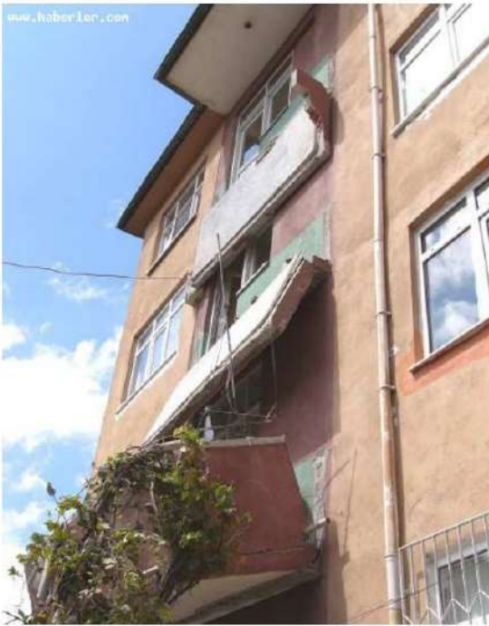
Figür 7. Balkonları konsol kirişlerle desteklenmeyen bir bina.
