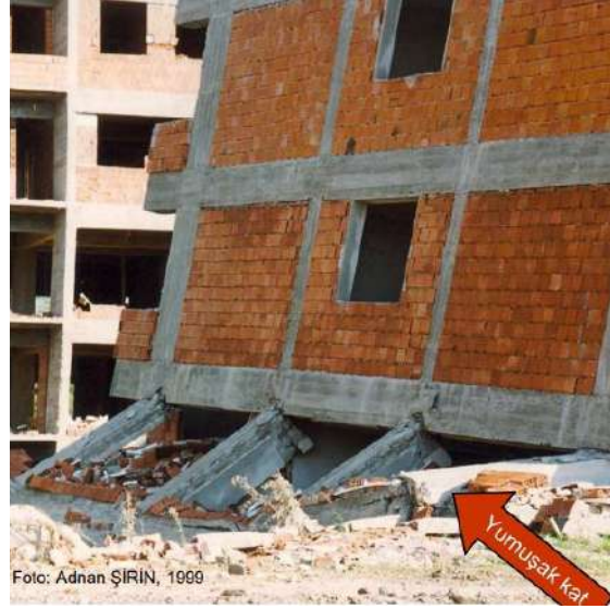
Figür 6. Zemin katı duvarsız tasarlanan binanın bu katları yumuşak kat tehlikesi oluşturmaktadır.
