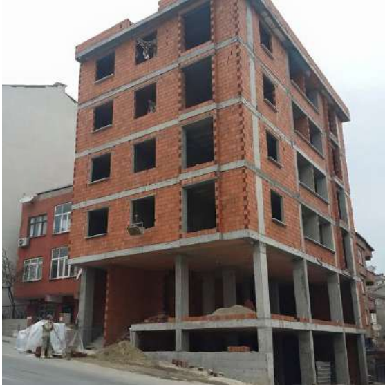
Figür 6. Zemin katı duvarsız tasarlanan binanın bu katları yumuşak kat tehlikesi oluşturmaktadır.
