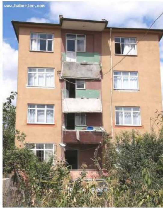
Figür 7. Balkonları konsol kirişlerle desteklenmeyen bir bina.
