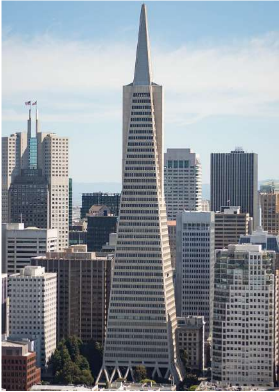
Figür 2. Dünyanın sismik olarak en hareketli bölgelerinden birisi olan San Francisco'da yer alan, her iki ekseninde tam simetrik Transamerica Tower (solda). Hollywood'da yer alan daire şeklindeki Capitol Records Building (sağda).
