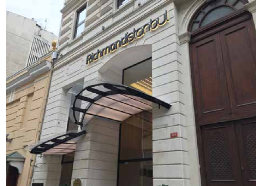
Resim 6. Şantiye devam ederken Richmond Hotel, İstanbul, 2014 (Kaynak: N. Toma)
