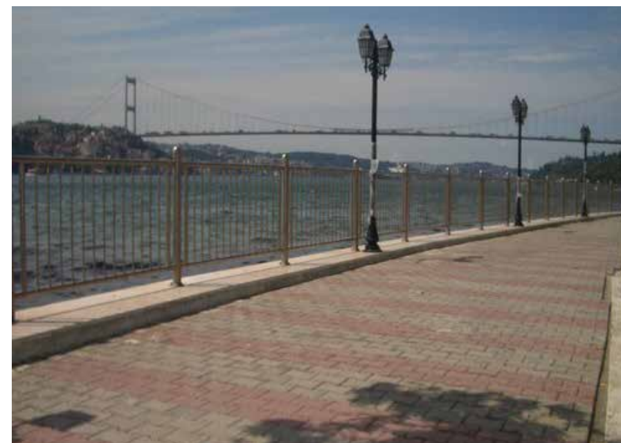
Resim 5: Sahil yürüyüş yollarında bulunan korkuluklar http://www.kardeslerpaslanmaz.com.tr/tr/sabanci-ogretmen-evianadolu-hisari-deniz-kenari-paslanmaz-korkuluk-uygulamasi (Ocak, 2017)
