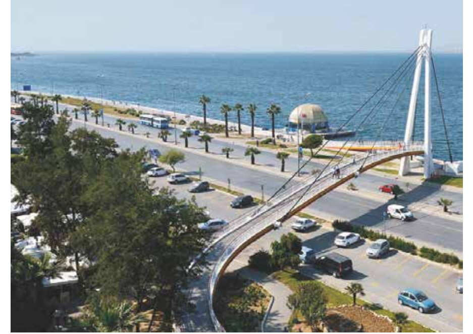
Resim 1: Eşit kullanıma uygun Göztepe yaya köprüsü http://www.tmb.org.tr (Ocak 2017)
