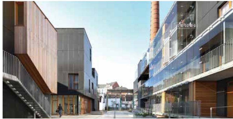
Resim 16a ve 16b: MDW Arkitektur, Heymans Sabun Fabrikası Konutları, Brüksel – Belçika
