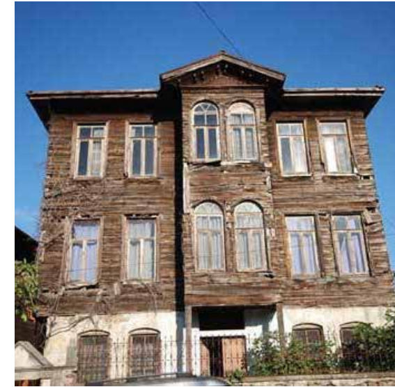
Figür 2. Kaf Konak, restorasyon öncesi dış görünüm giriş cephesi.
