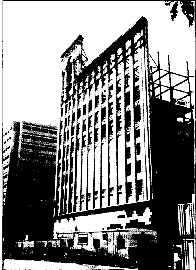
Washington D.C. de Restorasyon sırasında cepheler her iki yandan askıya alınmış ve bina oyulmuş.
