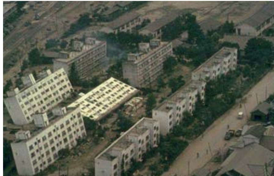
Figür 9. Yerin taşıma gücünü yitirmesi sonucu yapılar yana yatmış veya devrilmiştir, Kobe, 1995 (www.ce.washington.edu/liqufaction/html)
