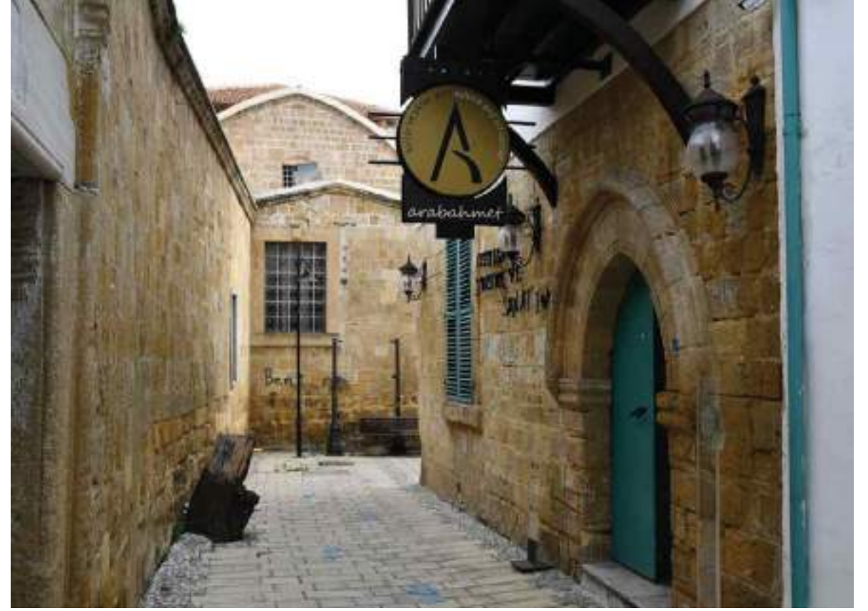
Figür 1. Arabahmet Kültür Evi Binası
