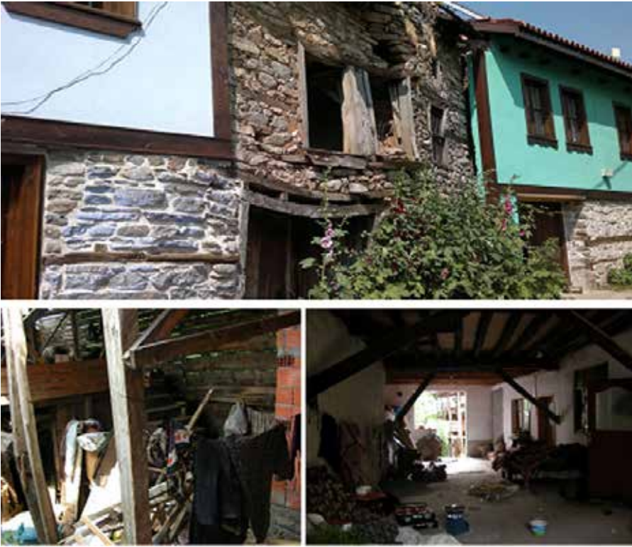
Figür 5: Cephe sağlamlaştırma yapılmasına rağmen iç mekânlar müdahalesiz bırakılmıştır, 2011
