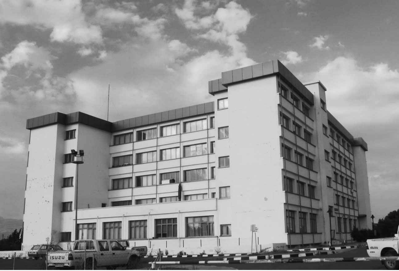
Figür 5: İçişleri Bakanlığı Binası.
