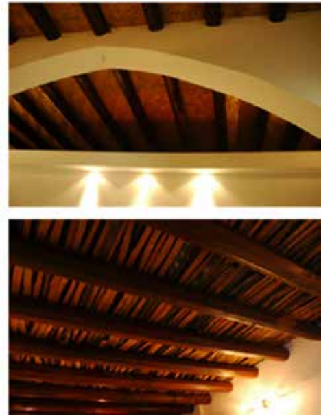
Figür 3: Geleneksel yapı teknikleri kullanılarak restore edilmiş binaların tavan detayları, 2011
