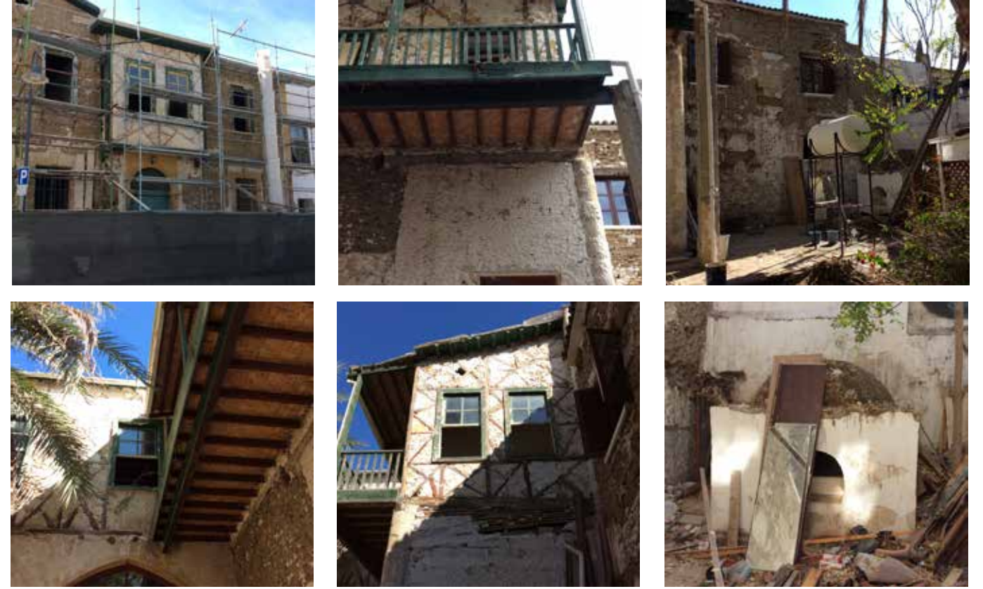
Figür 5. Restorasyon öncesi, binanın dış cephelerinin ve avludaki hamamın durumu. (Menteş, 2015)
