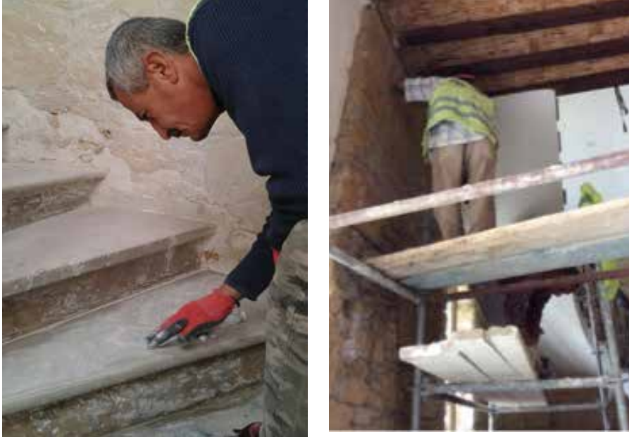
Figür 8. Restorasyon sürecinde merdivenlerin ve taş duvarların onarımını taş ustaları büyük bir özen ve titizlikle yapmıştır. (Menteş, 2016)
