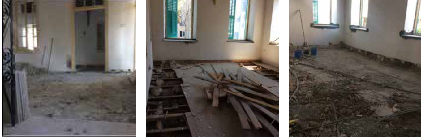
Figür 7. Restorasyon sürecinde, binanın üst katındaki zemin işleri. Üst kattaki giriş holünde zeminin orjinal Kıracı Köy mermerleri (Kıbrıs mermerleri) genellikle kırık ve kötü durumda olduğu için sökülüştür. Elektrik tesisatının yeniden döşenmesi ve orjinaline uygun yeni mermerlerin yerleştirilmesi için ön hazırlık çalışmaları yapılmıştır (sol Figür). Şu andaki yönetim kurulu odasındaki restorasyon öncesinde orjinal olmayan ve çürüyen zemin ahşaplarının sökülerek, elektrik tesisatının güncel hale getirilmesi ve yeniden orjinaline uygun hale getirilme çalışmaları (sağdaki iki Figür). (Menteş, 2016)
